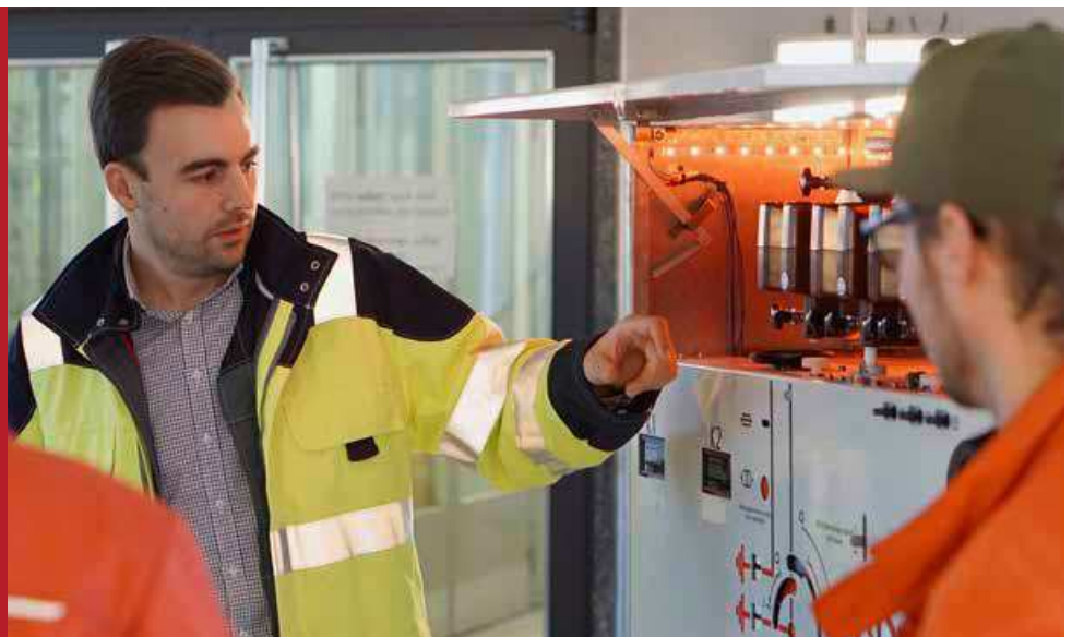
Seminarleiter Florian Pusch erläutert die technischen Details einer SF6-isolierten Schaltanlage im Schulungsraum der CUN in Bostel.
